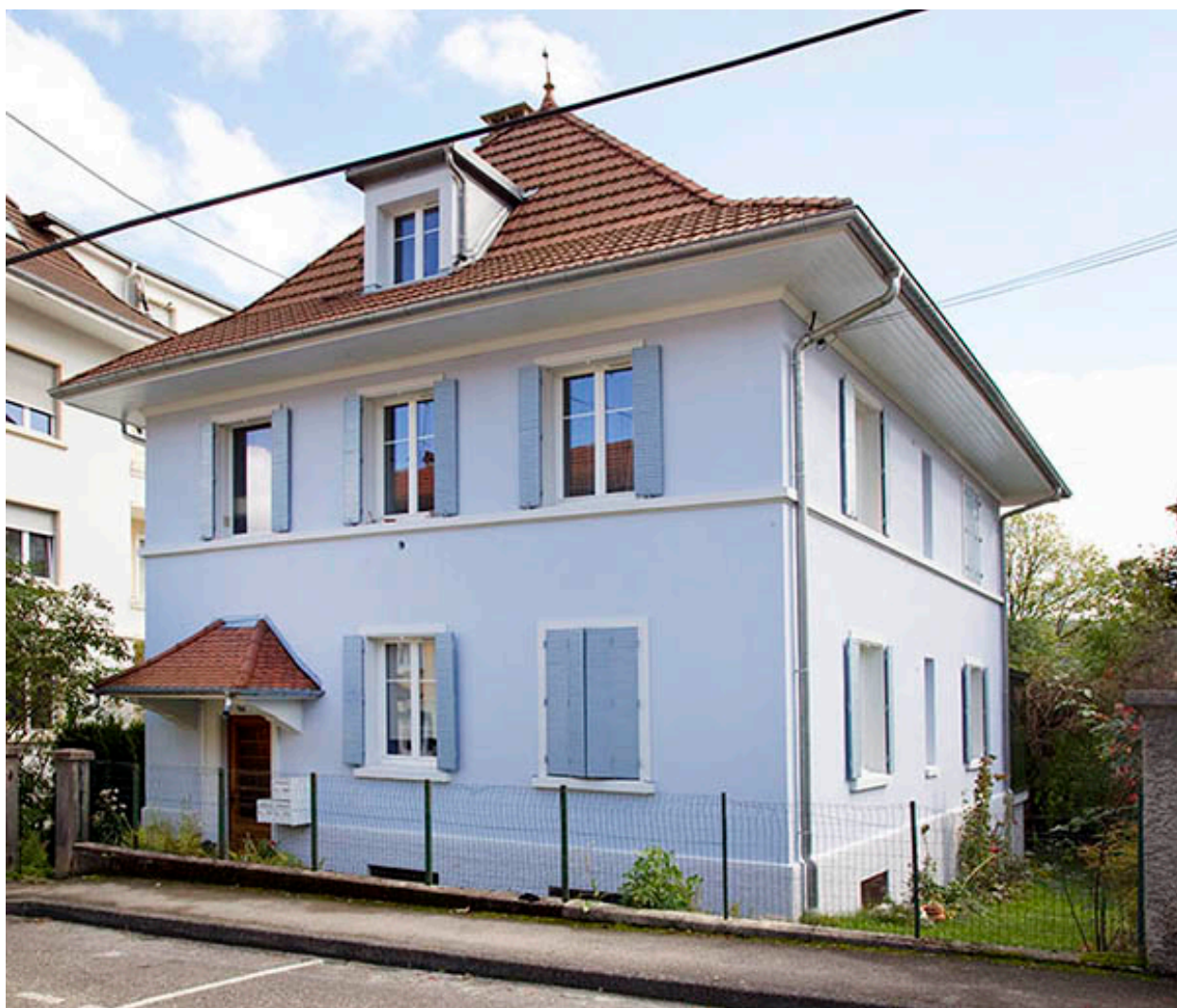
Façades antérieure et latérale droite.
