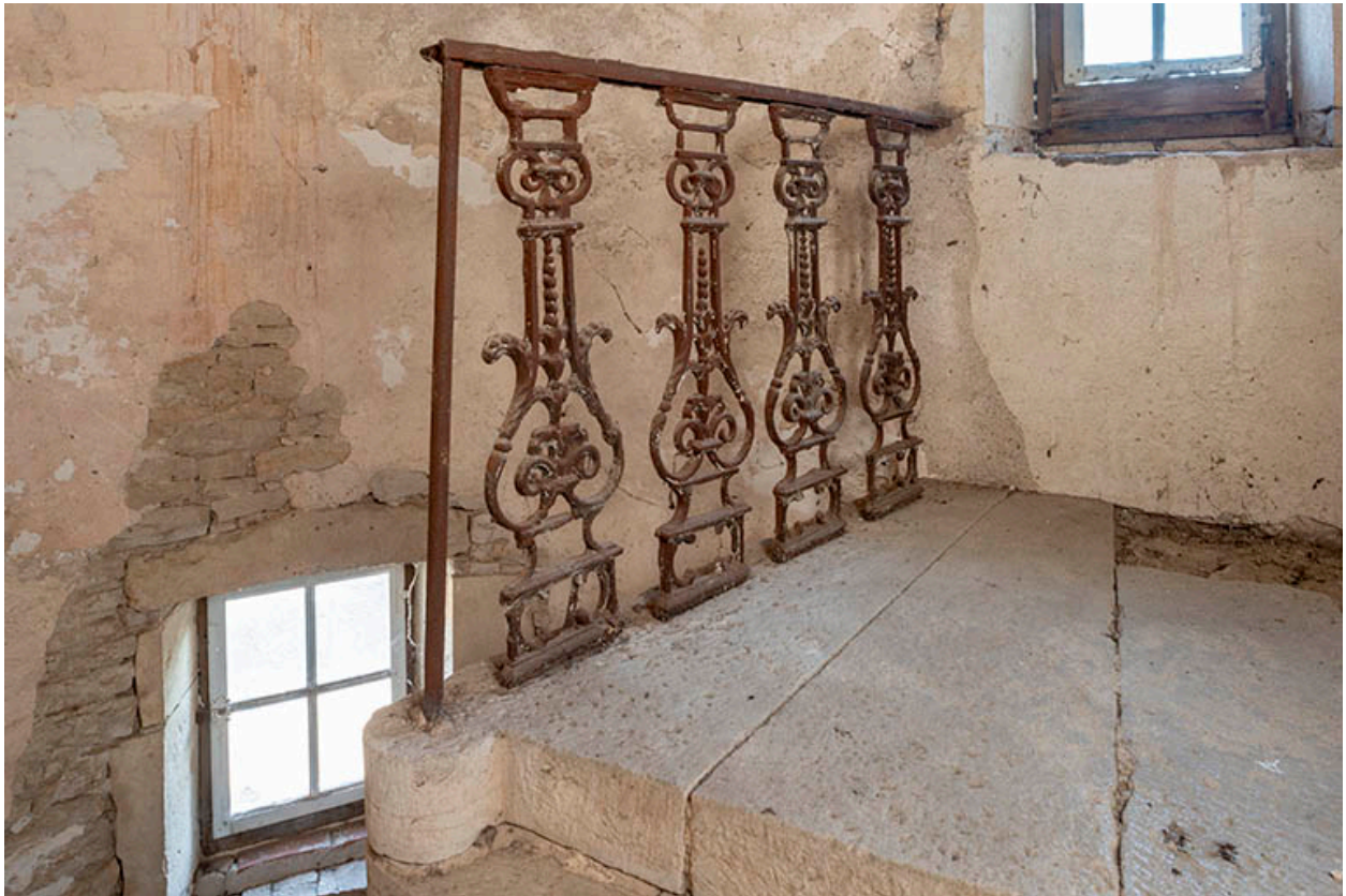
Escalier en vis, comble.
