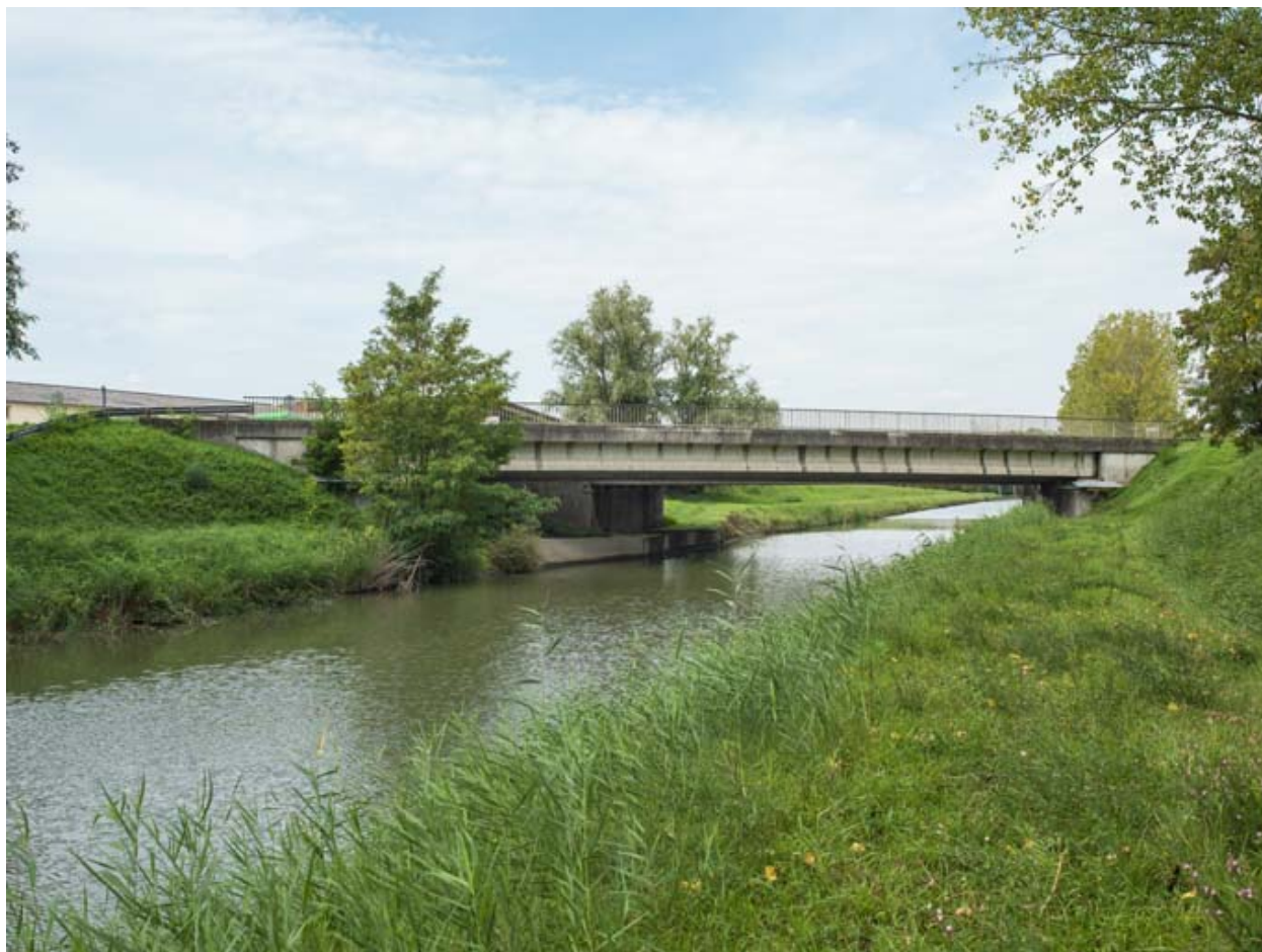
Vue d'ensemble du pont.
