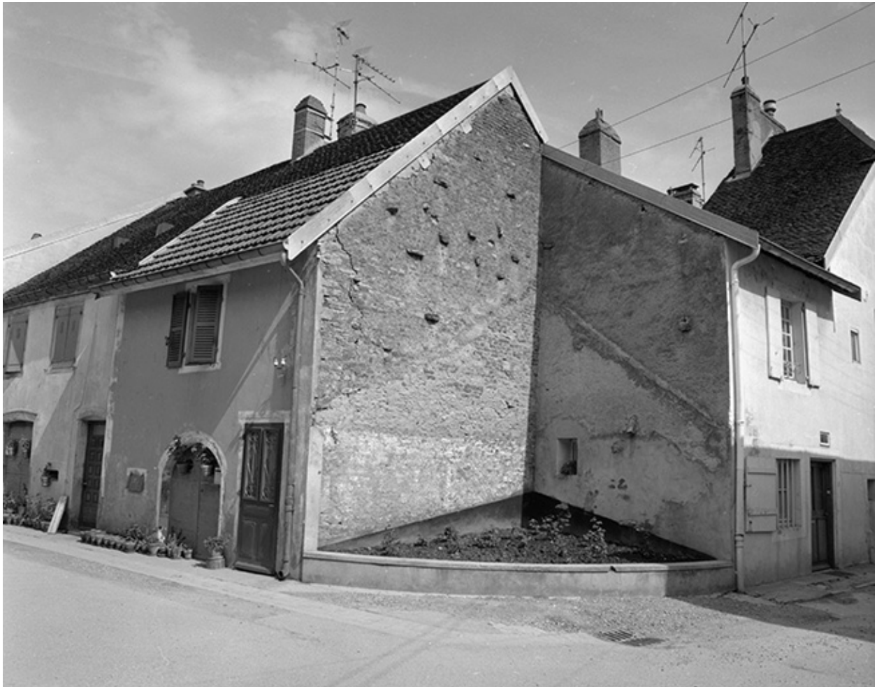
Façades antérieure et latérale droite.
