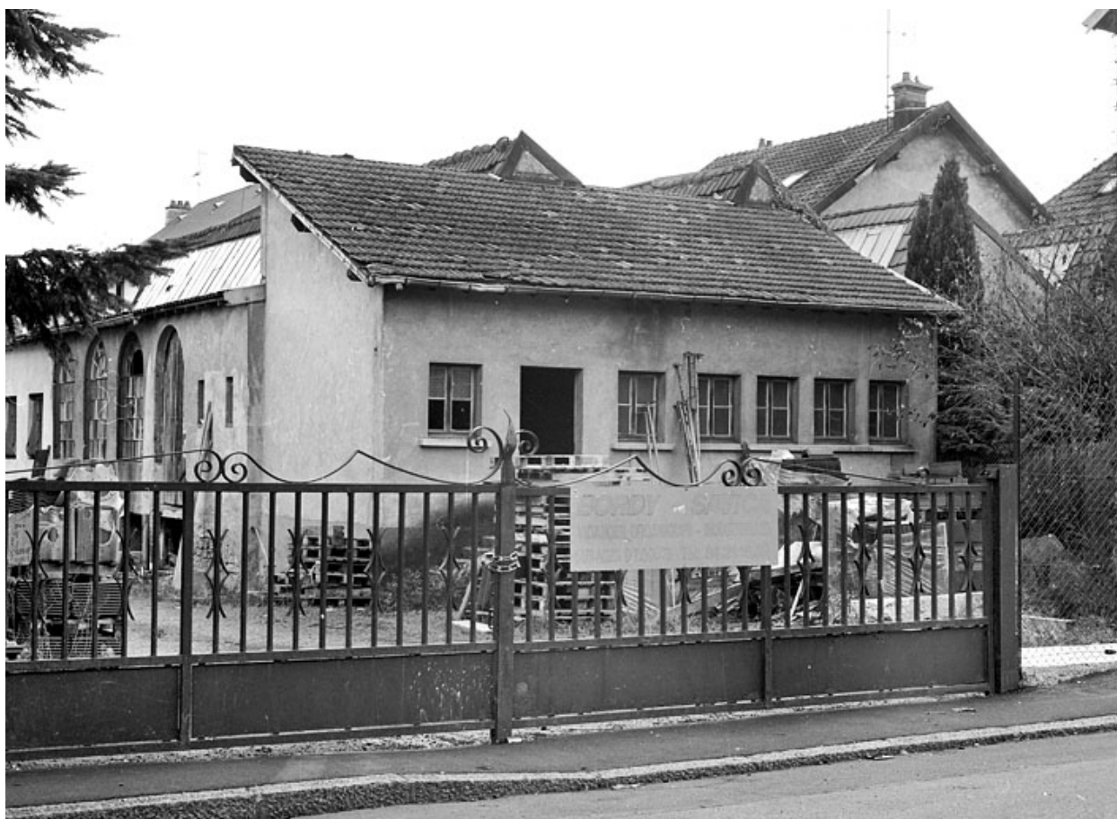
Vue arrière de l'atelier de fabrication.
