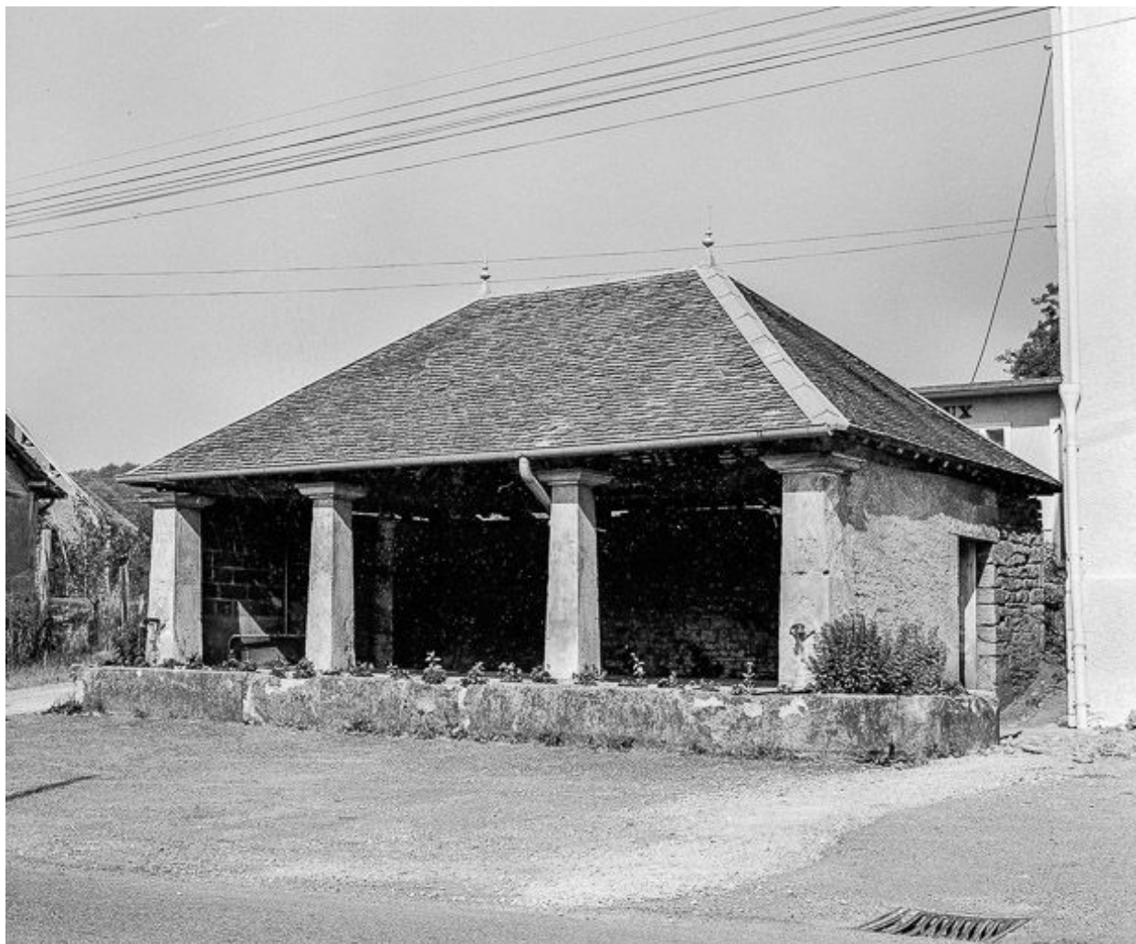
Extérieur, vue d'ensemble.
