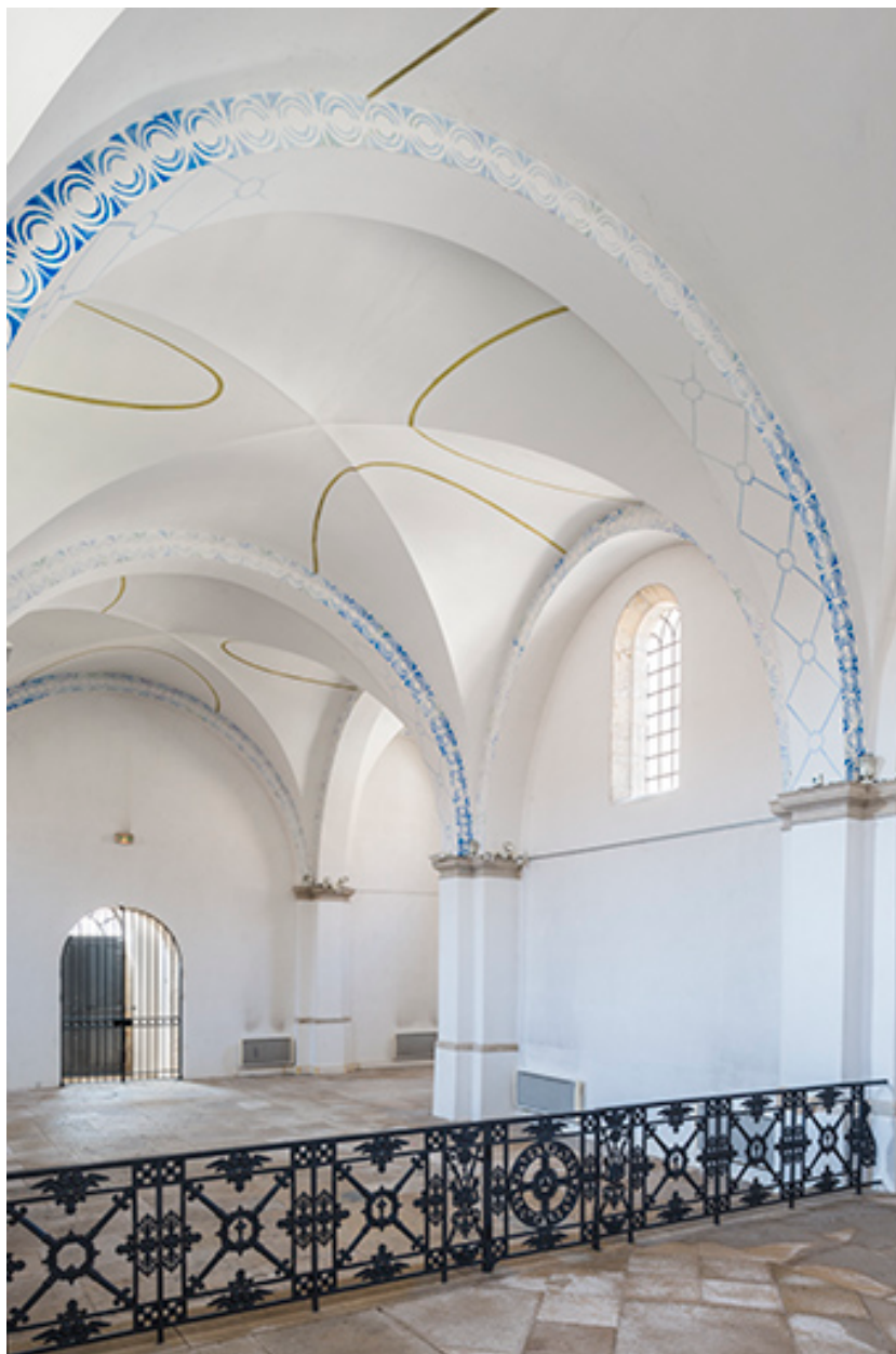
Vue du plafond en voûte.
