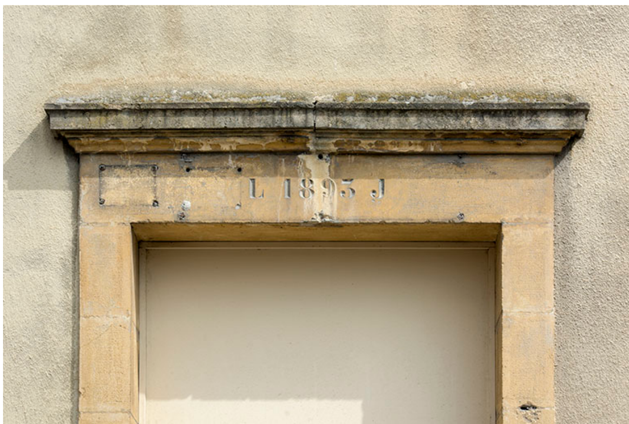
Bâtiment sur rue : linteau daté 1893.
