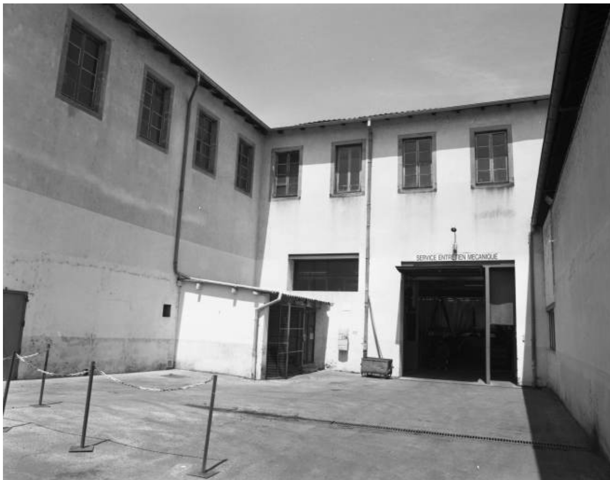
Atelier outillage-entretien mécanique. Façade sud.
