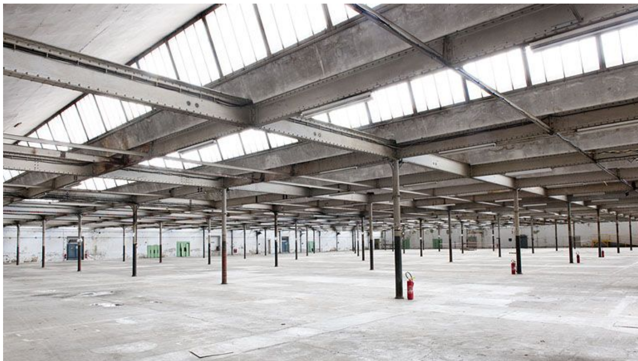
Salle de filature. Vue depuis le sud-est.
