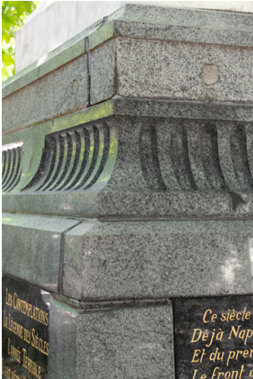
Monument dédié à Victor Hugo : détail du socle en porphyre vert fourni par la graniterie du Pont de Miellin.
