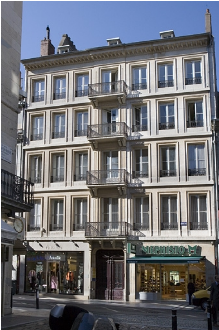
Vue d'ensemble de l'édifice depuis la rue.
