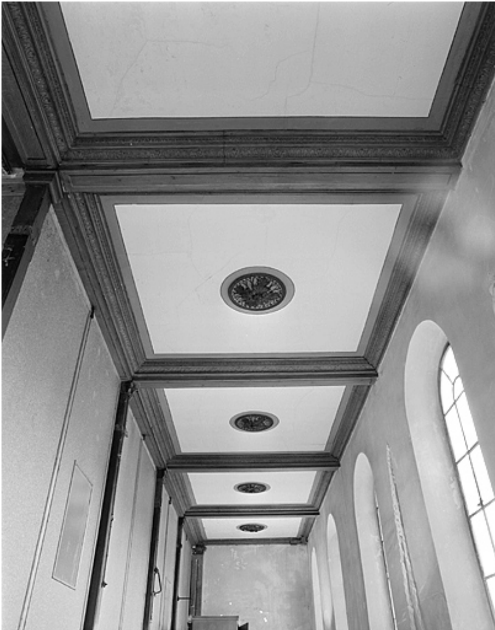
Plafond de la tribune sud.
