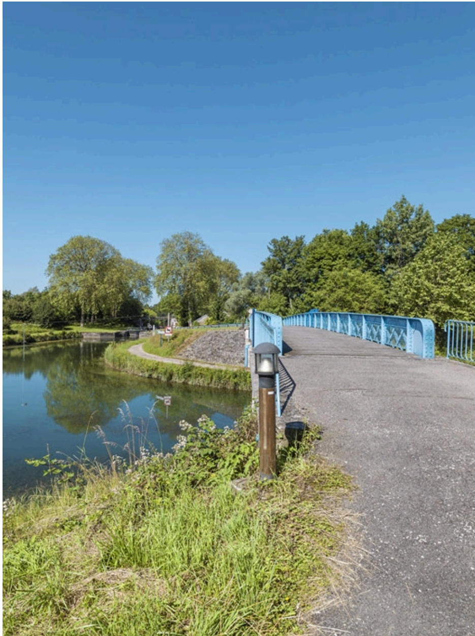
Vue du dessus, avec à gauche le site d'écluse 18.
