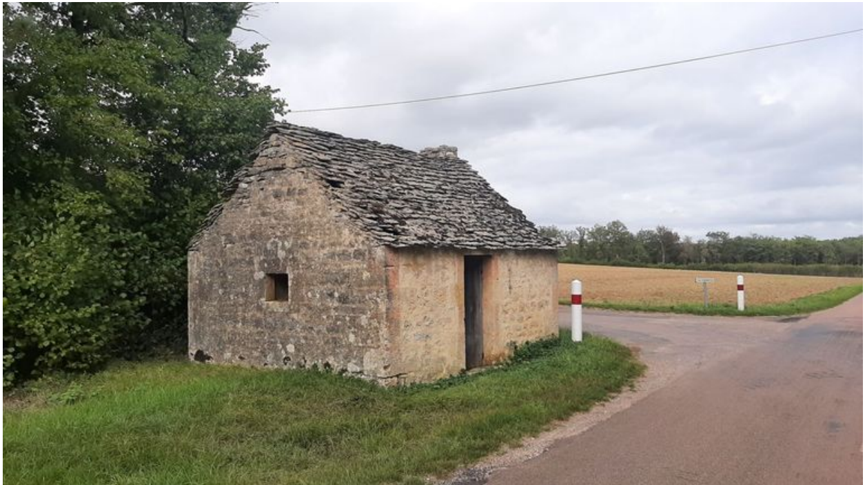
Vue de l'élévation sud de la cabane.
