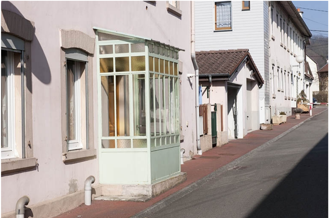
Façade sur rue d'une habitation à 8 logements.
