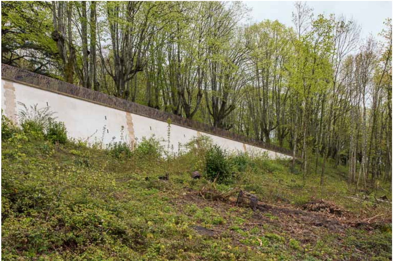
Terrasse, vue depuis la partie inférieure du parc.
