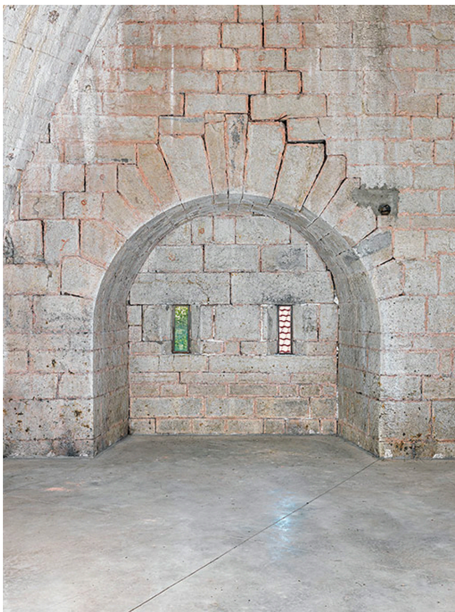
Bastion du puits : "alcove" avec embrasures de la face nord.
