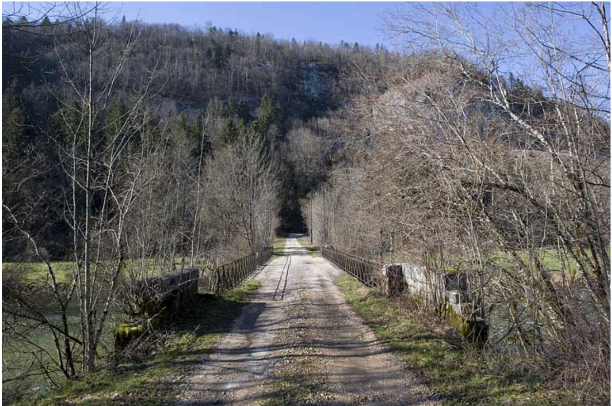
Vue d'ensemble du pont et du chemin de la Gare.
