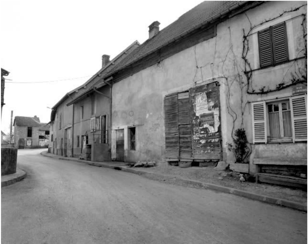
Ferme située 2 rue des Contrevaux.
