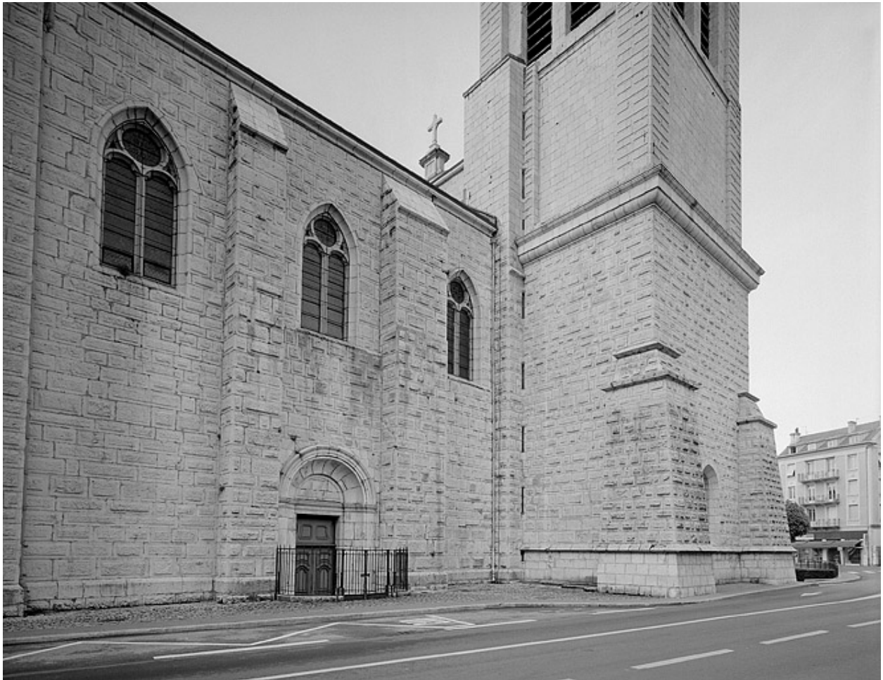
Vue des travées occidentales du flanc nord.
