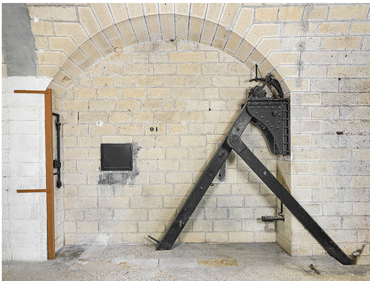
Mécanisme du pont-levis.
