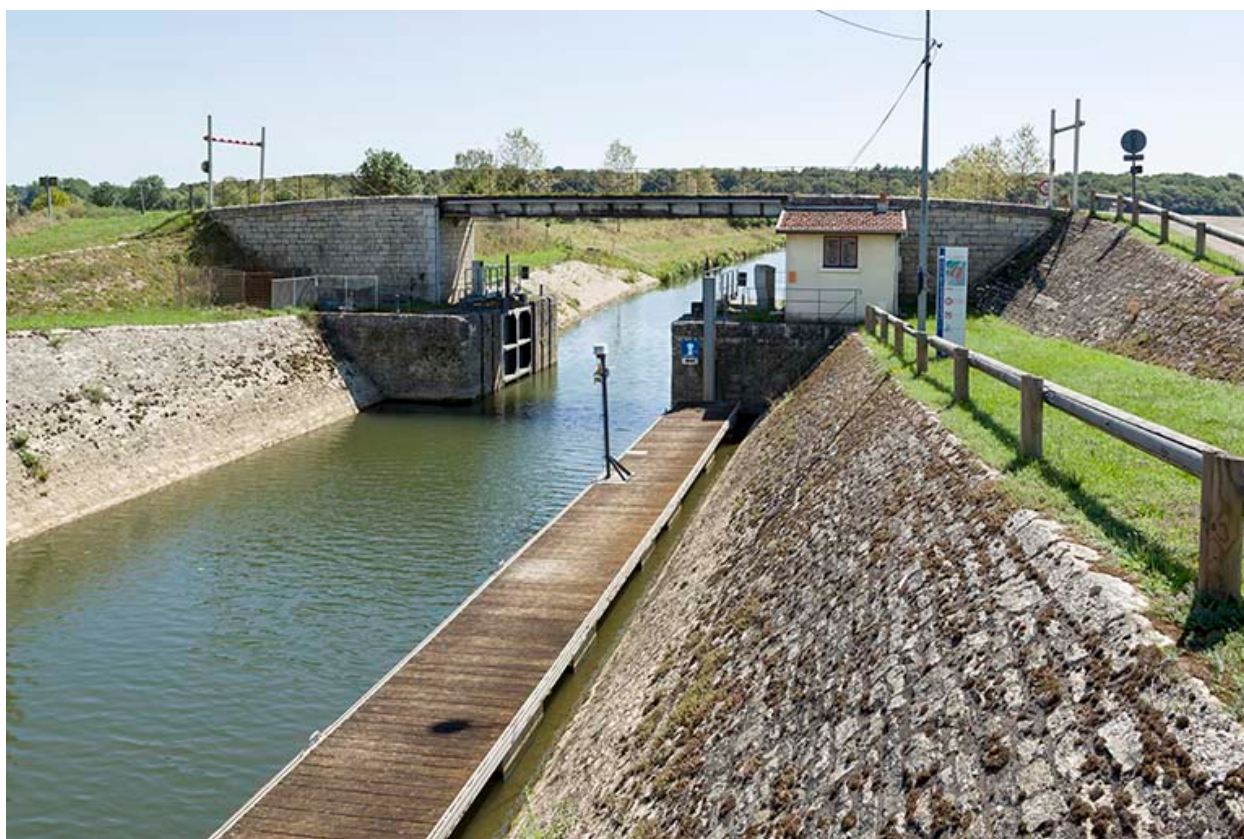
Le sas de l'écluse.
