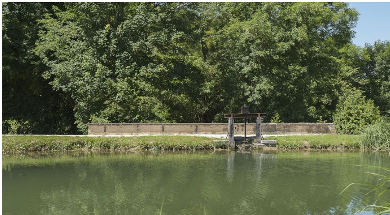
Déversoir rive gauche.
