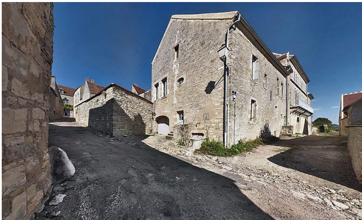
Vue d'ensemble des façades postérieures.
