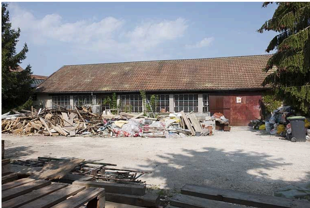
Façade sud de l'atelier de fabrication.
