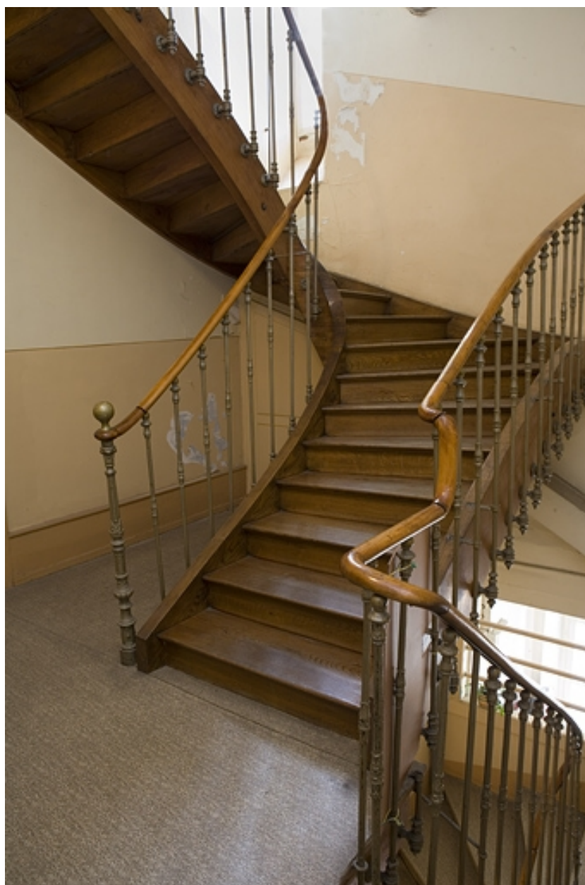
Bâtiment A. Vue de l'escalier.
