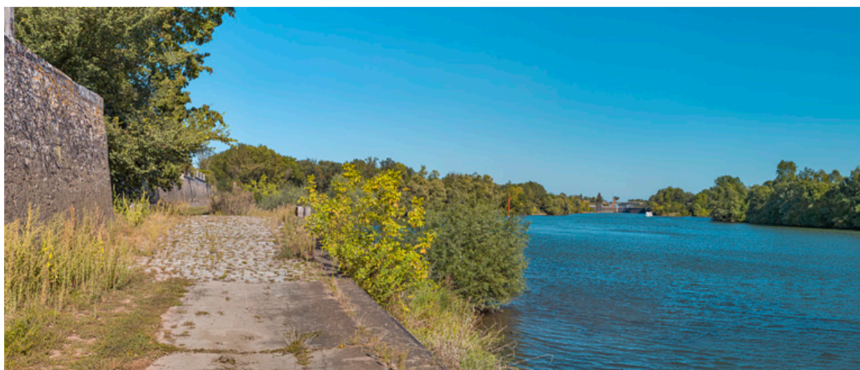
Pavage et ponceau sur la rive droite.
