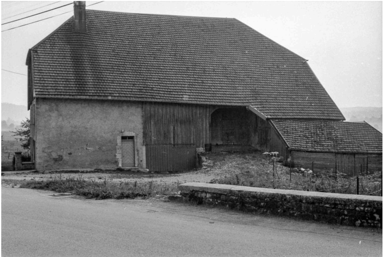
Façade latérale droite.
