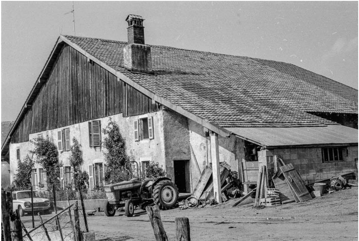
Pignon d'habitation et gouttereau postérieur.
