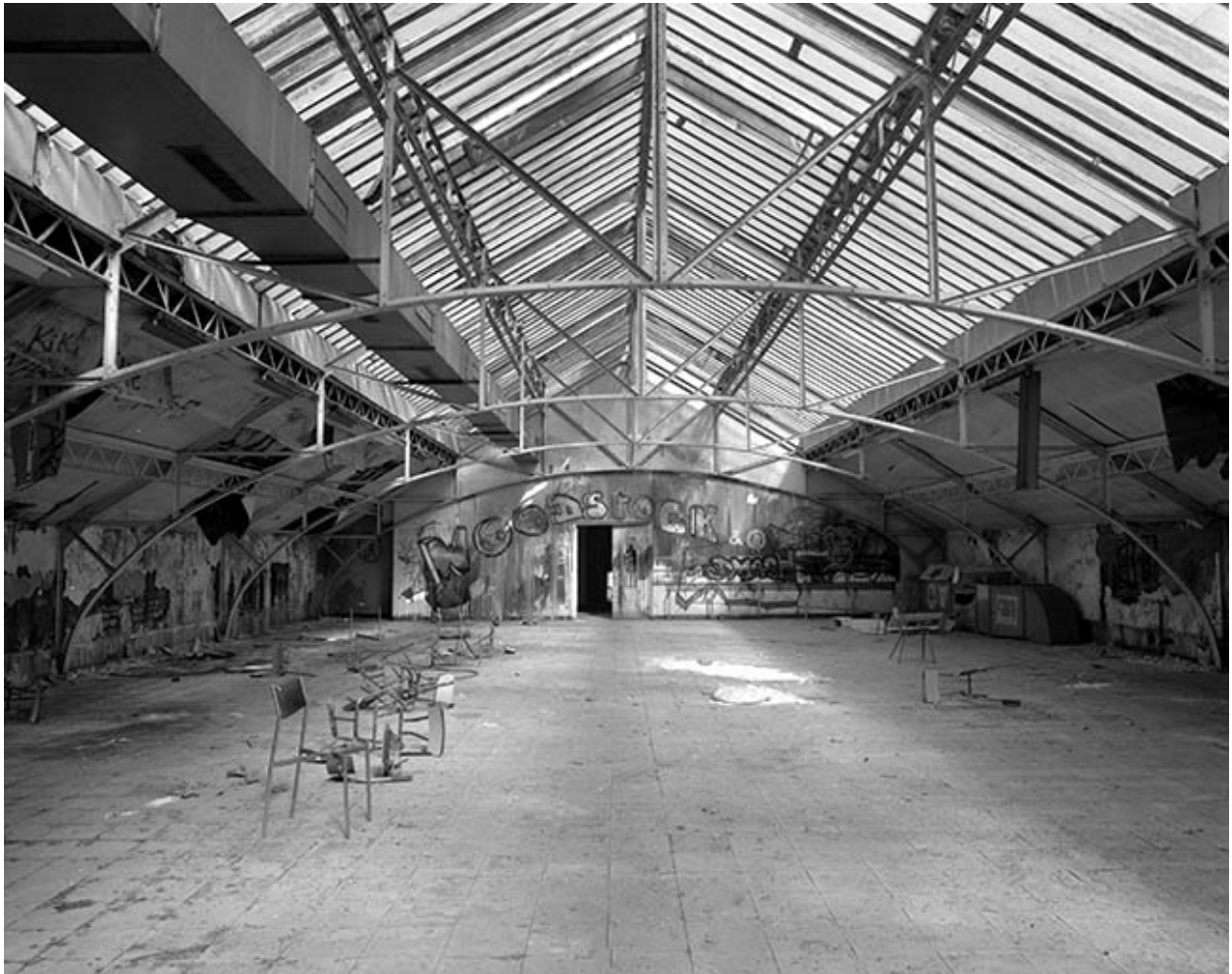
Charpente métallique et verrière de la cantine.
