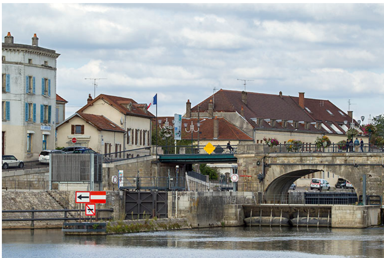
Le site d'écluse, vue aval.
