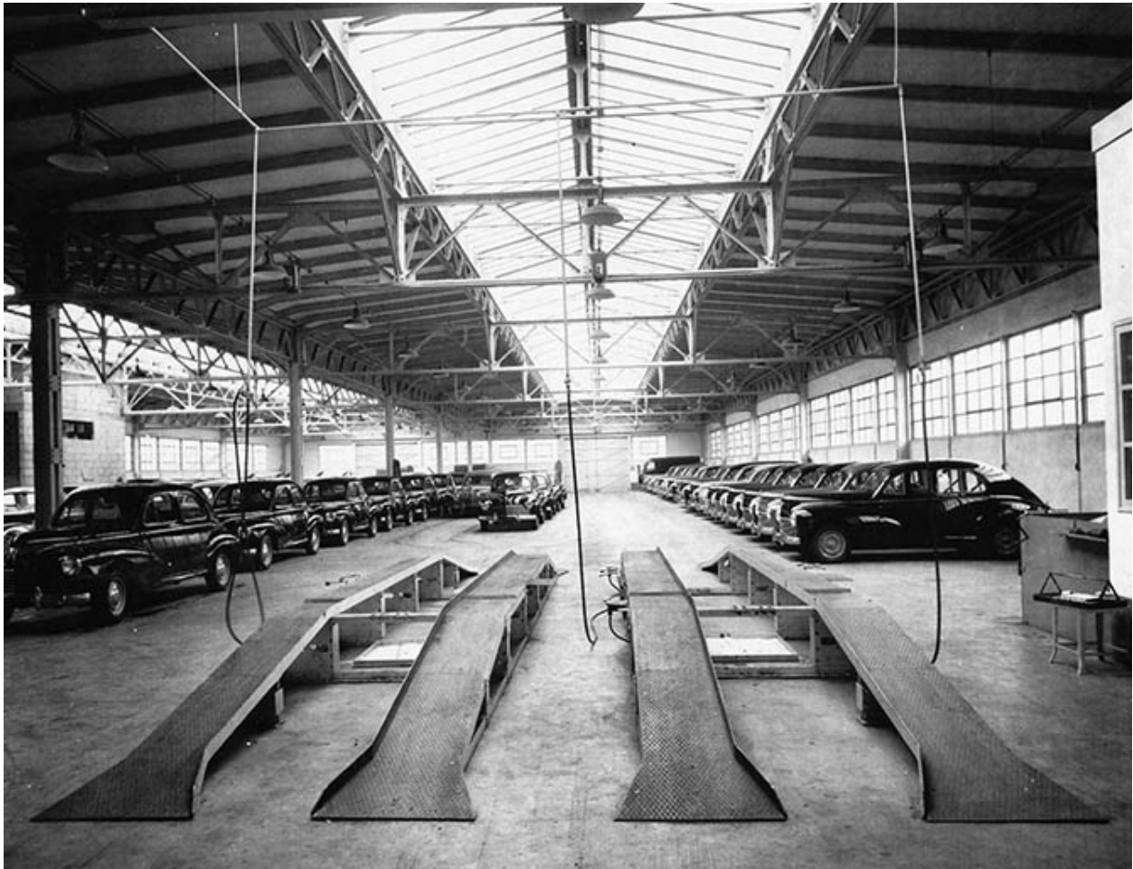
Centre de livraison (203).
