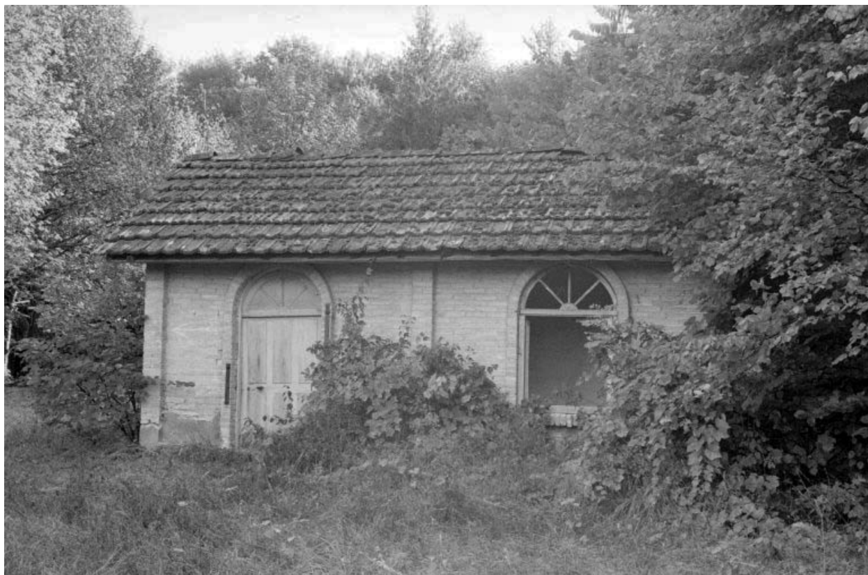
Façade antérieure du bureau dit l'huilerie.
