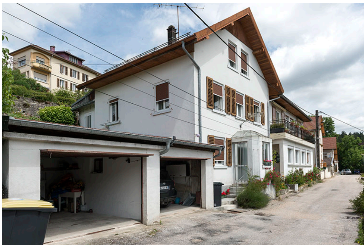
Façades antérieure et latérale gauche.
