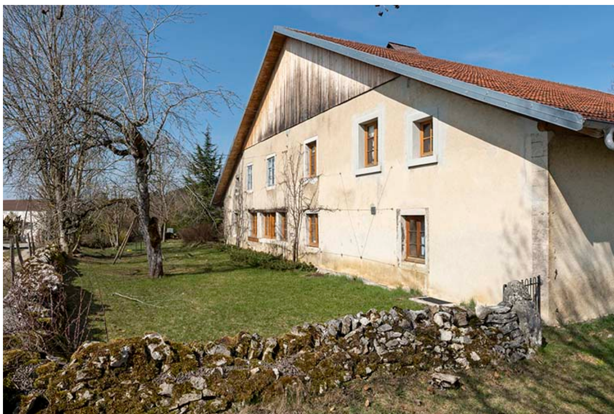
Façade sud, vue en enfilade.
