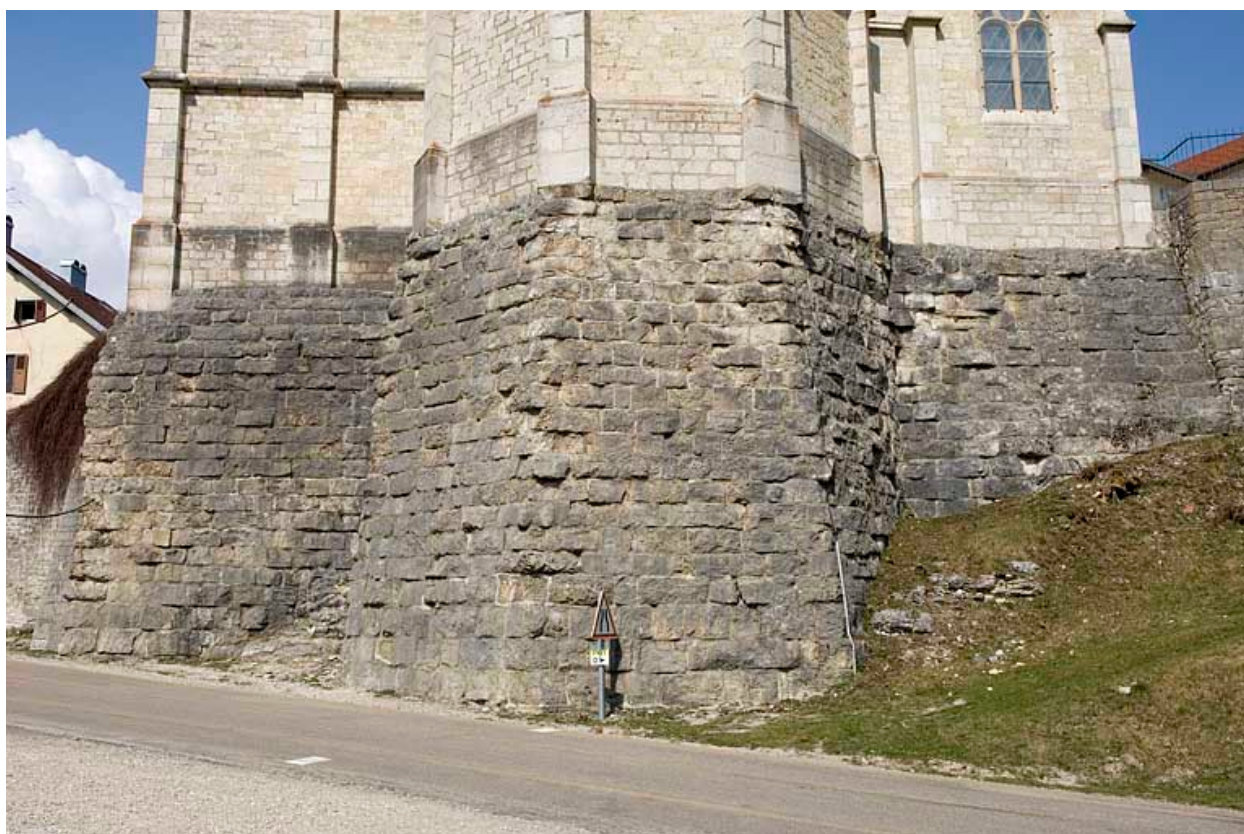
Mur de soutènement du chevet de l'église.
