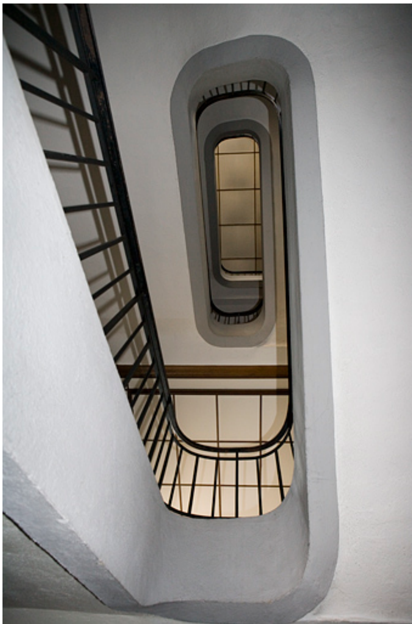
Cage d'escalier : escalier vu en contre-plongée.
