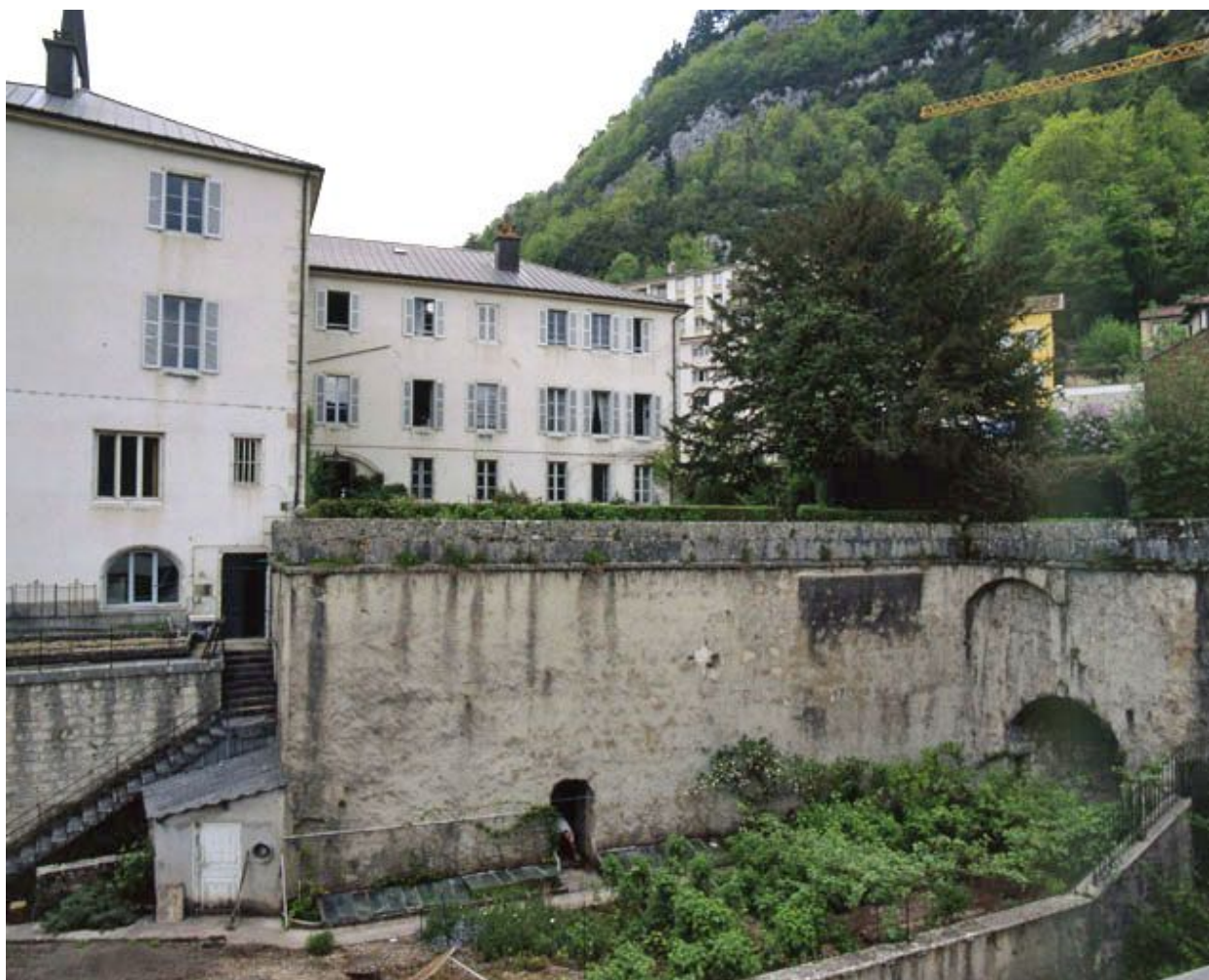
Partie droite des façades postérieures.
