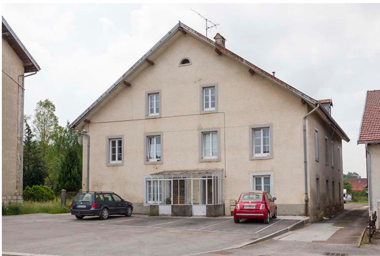
Le logement patronal.
