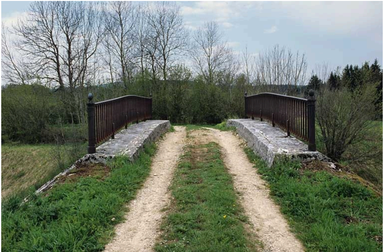
Vue d'ensemble du tablier.
