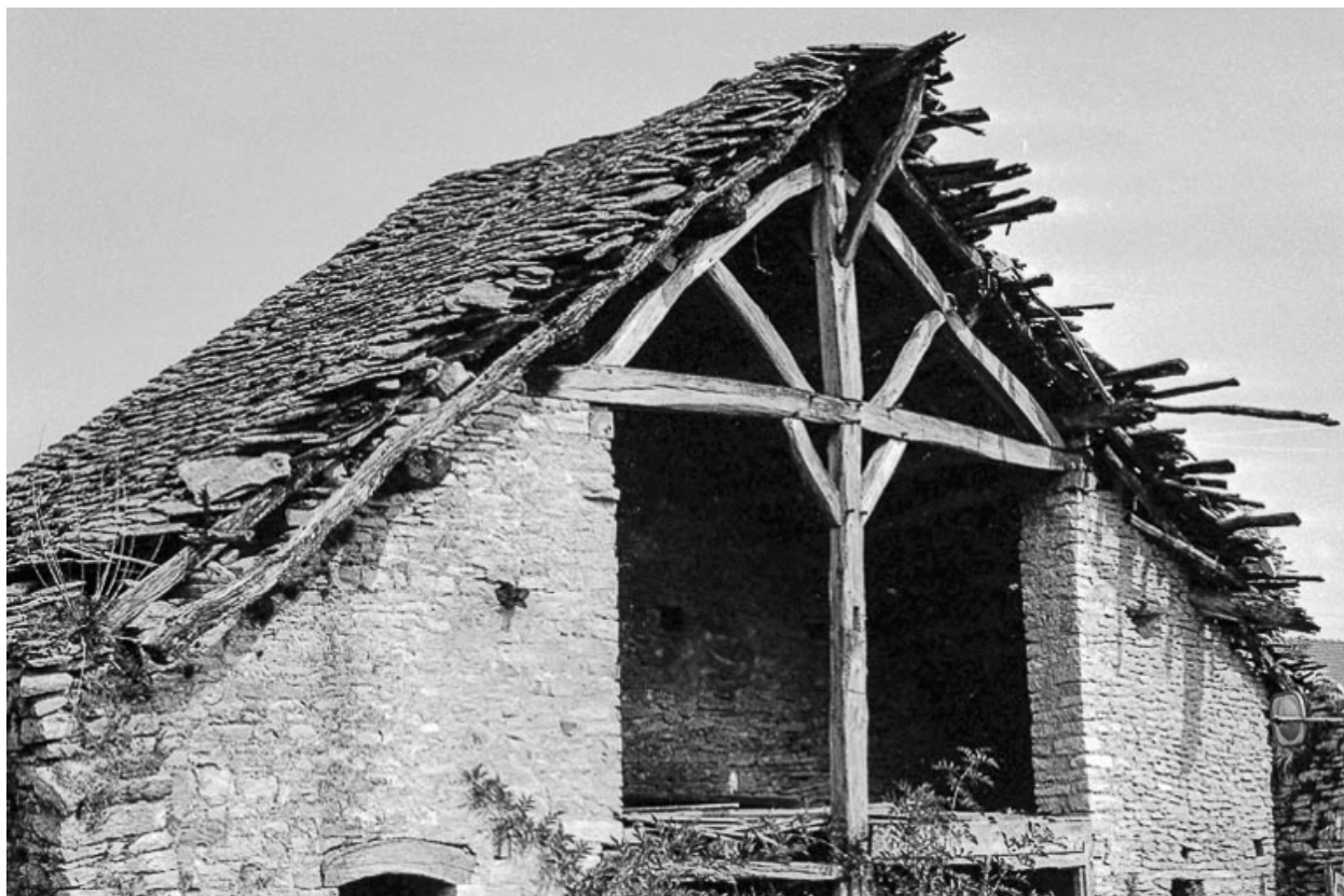
Ferme cadastrée B3 256 : toiture.
