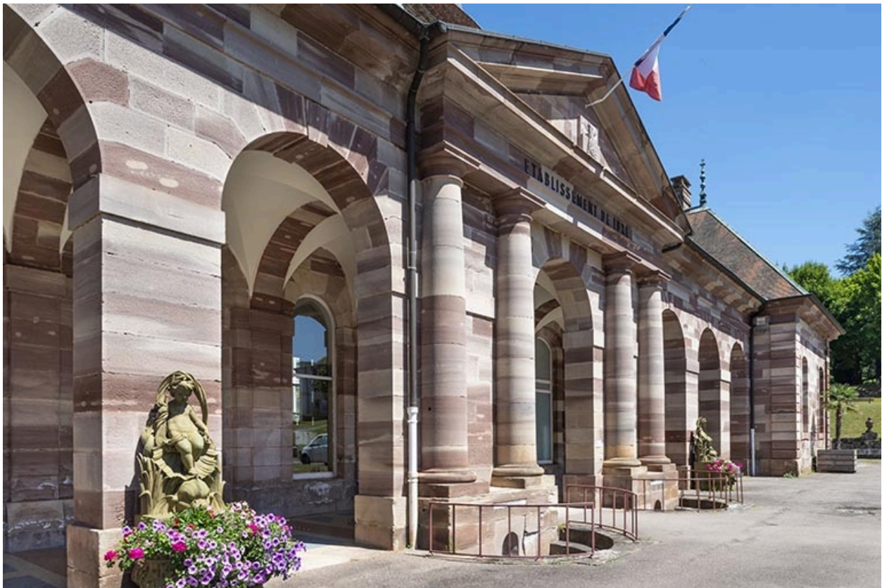
Bâtiment nord dit du Grand Bain, façade sud.
