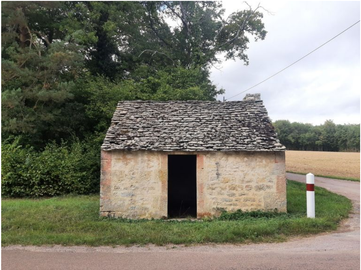
Vue de l'élévation sud de la cabane.
