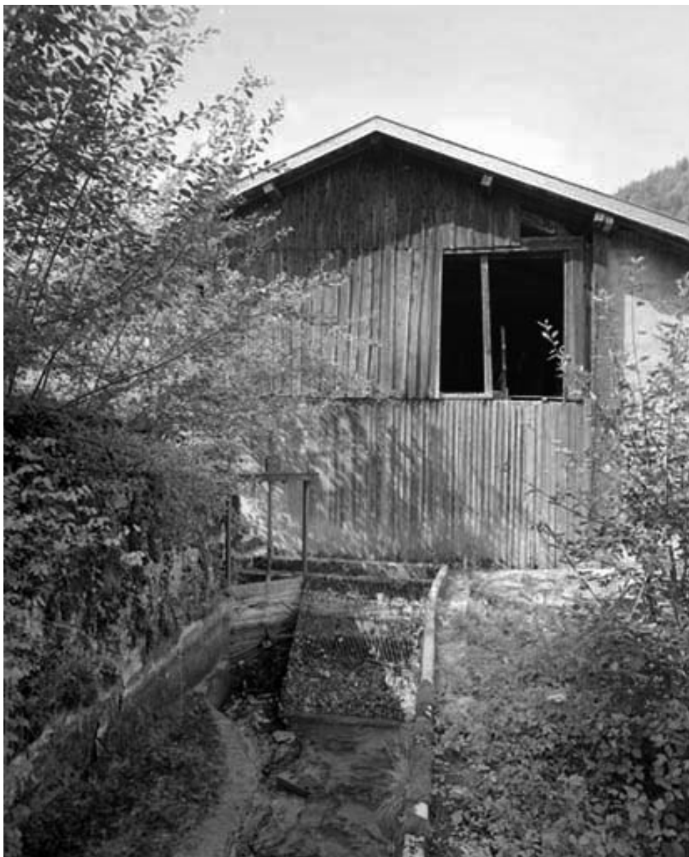
Canal d'amenée et bâtiment d'eau (ancienne scierie).
