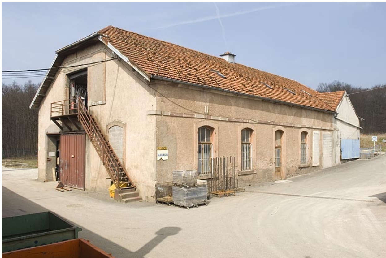
Moulin d'aval. Vue de trois quarts.
