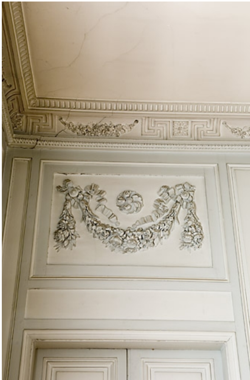
Détail du décor au-dessus d'une porte de la chambre à gauche du salon.
