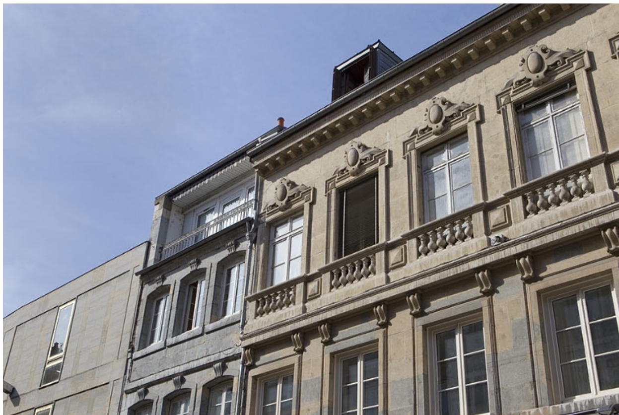
Détail de la surélévation en retrait sur rue.
