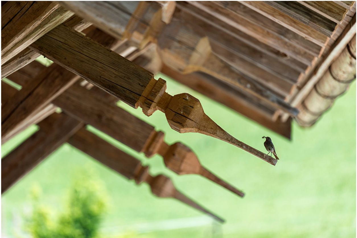
Extrémité sculptée des arbalétriers (façade antérieure).
