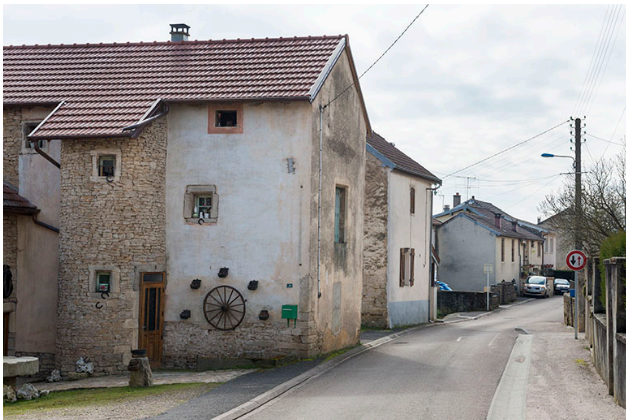
Ferme en équerre dotée d'une tour.
